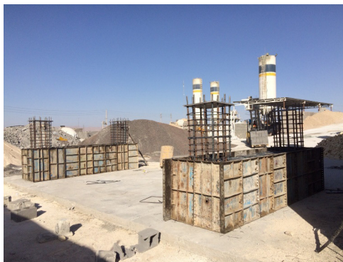
شکل ۵- فونداسون در مرحله قالب بندی
