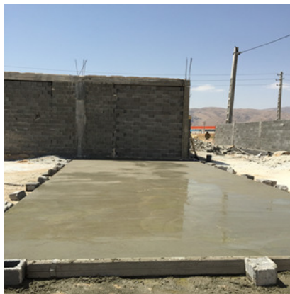
شکل ۴- بتن مگر در آزمایش انجام شده
